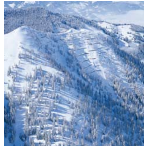
Kirchlespitz, Steg-Malbun: Dort, wo der Wald seine Lawinenschutzfunktion nicht ausreichend erfüllen kann, sind technische Verbauungen erforderlich.
