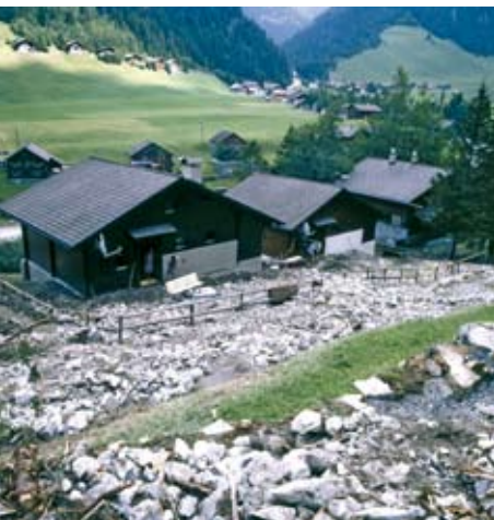
Wisli, Kleinsteg (1995): Ein Rüfegang hat die Ferienhäuser teilweise mit Geröll und Schlamm eingedeckt.
