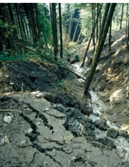
Teufibach, Triesenberg (1995): Wenn der Waldboden die Niederschlagsmenge nicht mehr aufnehmen kann, führen grosse Wasserabflüsse oft zu Eintiefungen der Bachsohle und Rutschungen der seitlichen Einhänge.
