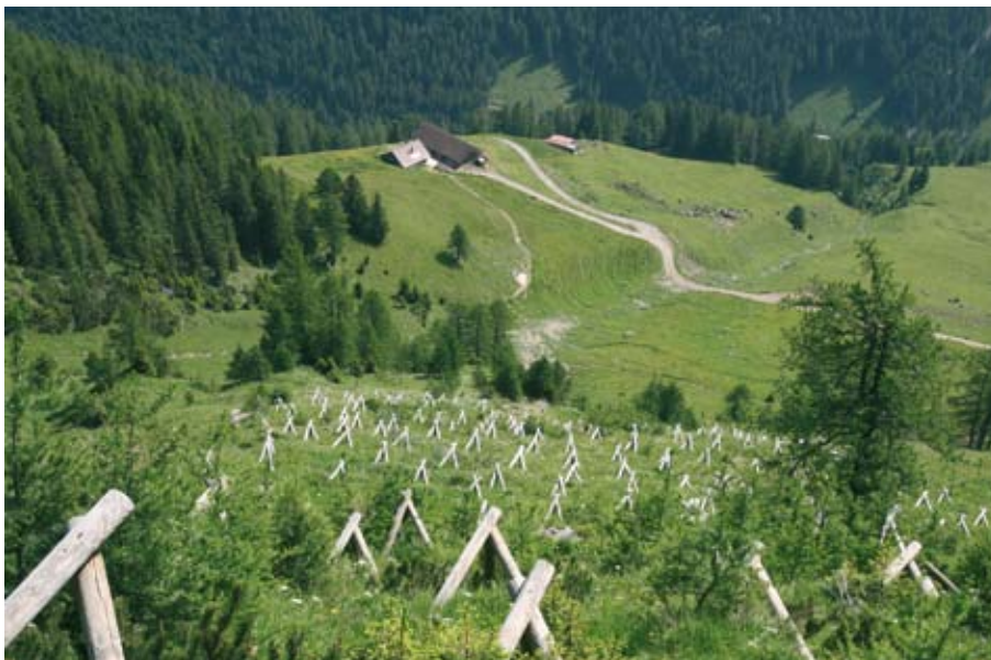
Lerchabühel, Alpelti: Dreibeinböcke verhindern in Steillagen das Ausreissen junger Pflanzen durch Schneekriechen und Schneegleiten.
