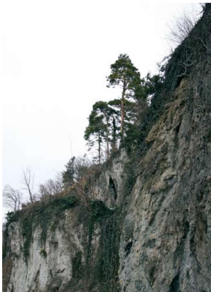
Schloss-Strasse, Vaduz: Fotos vor und nach dem Eingriff bilden wertvolle Hilfsmittel für die Erfolgskontrolle im Schutzwald.
