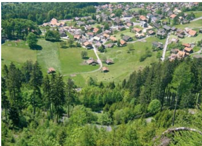
Links: Nur ein intakter Schutzwald kann die Triesenberger Weiler Steinort und Lavadina wirkungsvoll vor Steinschlag und Lawinen schützen.
