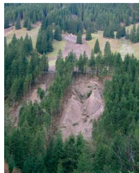
Rieter, Gross-Steg (2005): Bei mittel- und tiefgründigen Rutschungen gelangt die Waldwirkung an ihre Grenzen.
