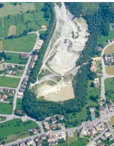
Quaderröfi, Schaan-Vaduz: Vorausschauend wurden Gebiete von Überbauung freigehalten, sodass später grosszügige Geschiebe- und Schlammstammler erstellt werden konnten.
