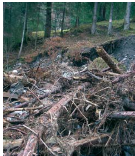
Chauftobel, Steg: Schwemholz führt zu Verklausungen, welche an Engstellen zu einem gefährlichen Gerinneausbruch führen können.
