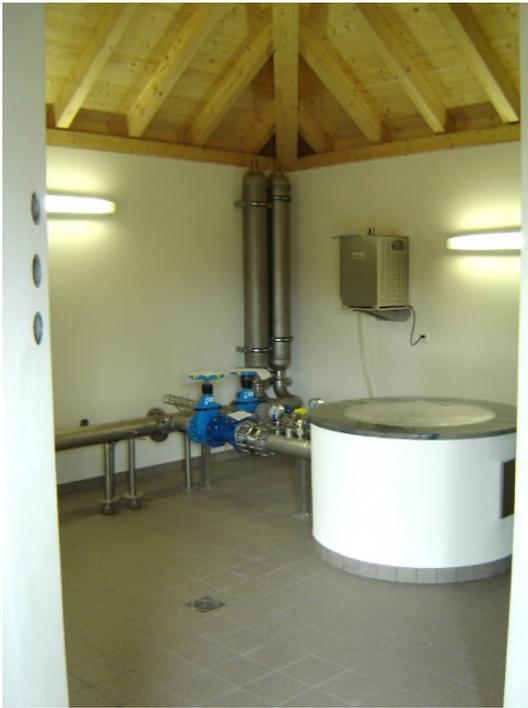
**Foto 1:** Trinkwasserversorgung: Innenansicht eines Grundwasserpumpwerks mit Brunnenchacht und Armaturen (Quelle: Dr. Bernasconi AG).
