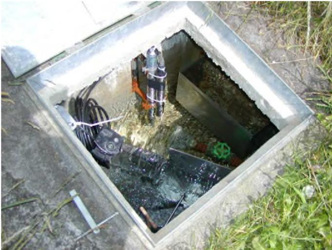
**Foto 6:** *Grundwasserüberwachung: Installation im Quellschacht zur automatischen Erfassung der Schüttung, der Temperatur und der elektrischen Leitfähigkeit (Quelle Rietli, 2001).*
