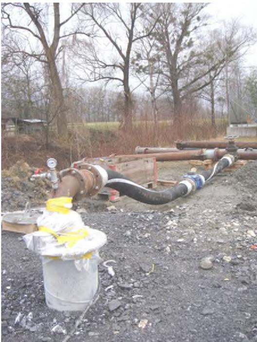
**Foto 2:** Thermische Nutzung: Installation für den Pumpversuch beim Neuerstellen eines Brunnens für die thermische Nutzung beim geplanten Neubau der FL Telecom in Vaduz (2011).
