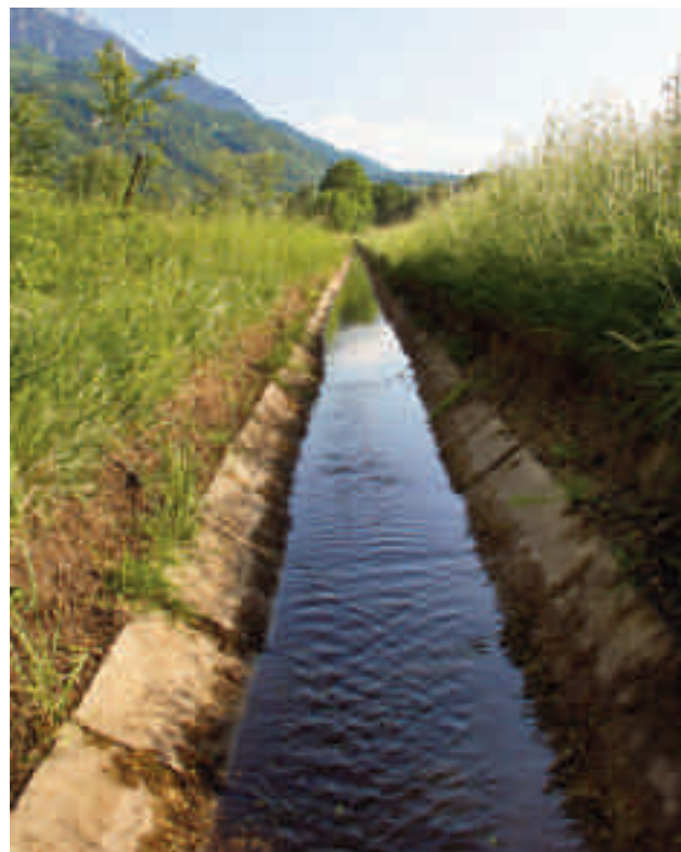
Abb. 21 Ein hart verbauter Entwässerungsgraben beim Erlenbach
