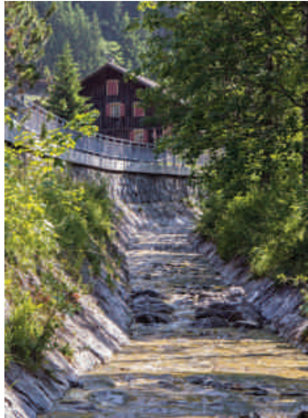
Abb. 21 Ein hart verbauter Entwässerungsgraben beim Erlenbach
