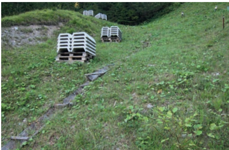
Abb. 38 Oberhalb des Pumpwerks Rieteren wurden Teile der Steger Rieter zur Hangsicherung entwässert. Die Betonprofile, die bei der bevorstehenden Erneuerung der alten Holzableitungen eingebaut werden, wurden bereits vor Ort gebracht.
