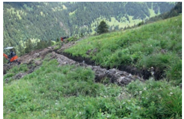
Abb. 30 Bau einer Quellfassung auf Mittlervalorsch. Ein kleines Quellhangmoor wird zerstört.
