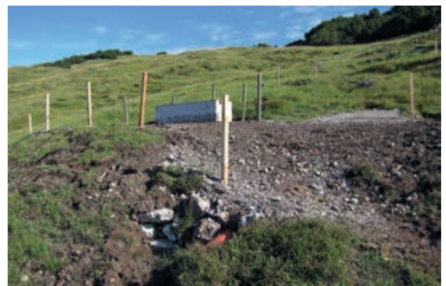
Abb. 31 Neu errichtete Tränkanlage in einem Quellhangmoor auf Matta/Gamperhöhe.
