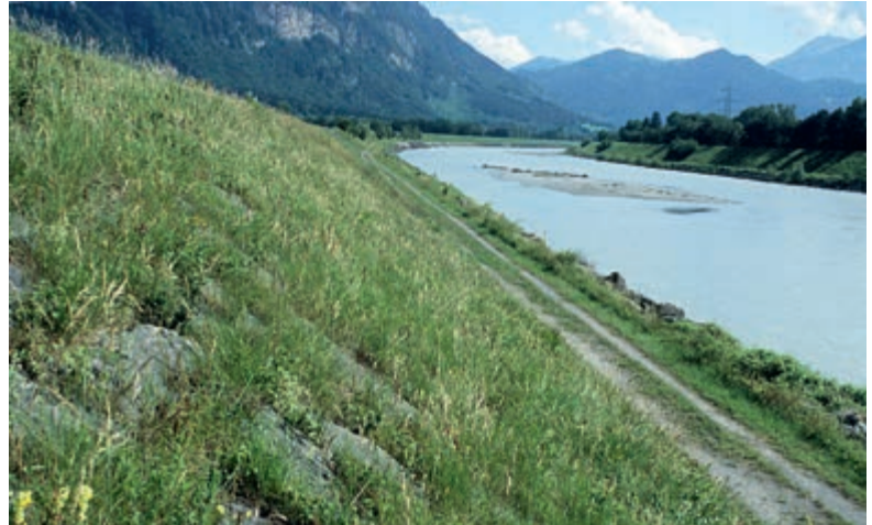
Abb. 9 Rheindamm bei Balzers mit typischer lückiger Vegetation auf der Wasserseite
