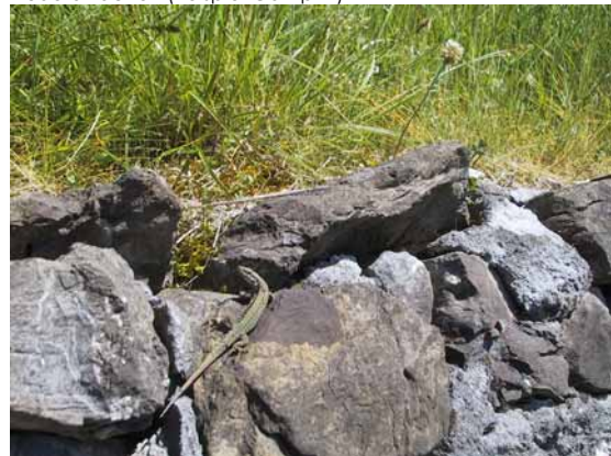
Trockenmauer (Beispiel Triesen)
