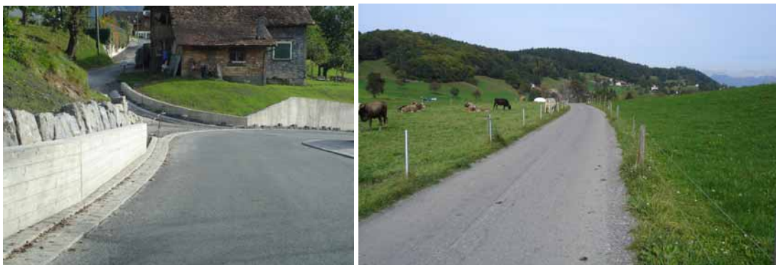
Moderner Mauerersatz bei historischer Strasse. Von der hist. Substanz ist nichts mehr zu sehen, nur noch die geschwungene Form lässt auf das Alter der Strasse schliessen.
