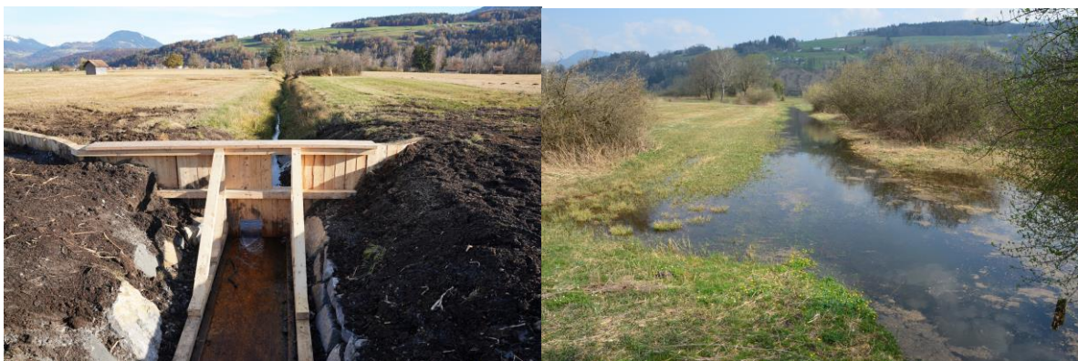
Abb. 12: Bau eines regulierbaren Einstaubauwerks im Oktober 2021 (links) mit Grundablass. Wassereinstau durch einen Biberdamm im Oberlauf (rechts).
